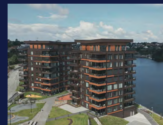
Foto Trinn 1 og 2 som allerede er bygget. Det blir samme type materialbruk i Trinn 3 og 4.
